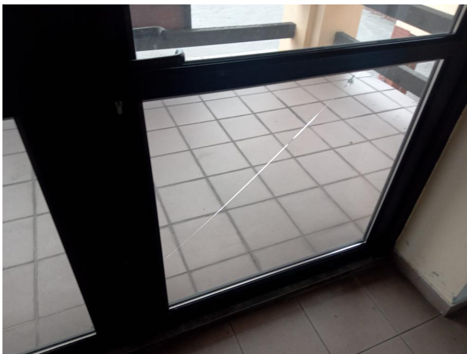
Rysunek 10 Pęknięta szyba
